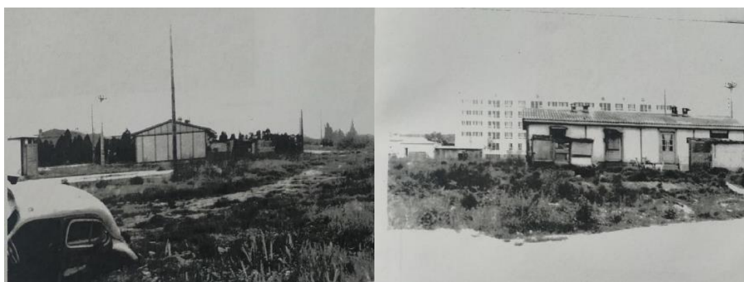
Ex-cité familiale de transit du Pont des Anglais en 1973. Sur la photo de droite, on peut voir le foyer Sonacotra en arrière-plan (source : archives du CALD, thèse de Pierre Waechter, p. 183)
